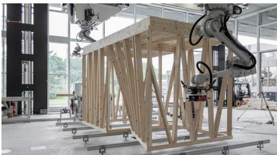
Eines von insgesamt sechs räumlichen, geometrisch individuellen Holzmodulen, das mit dem neuen robotischen Bauverfahren «Spatial Timber Assemblies» vorgefertigt wurde.
